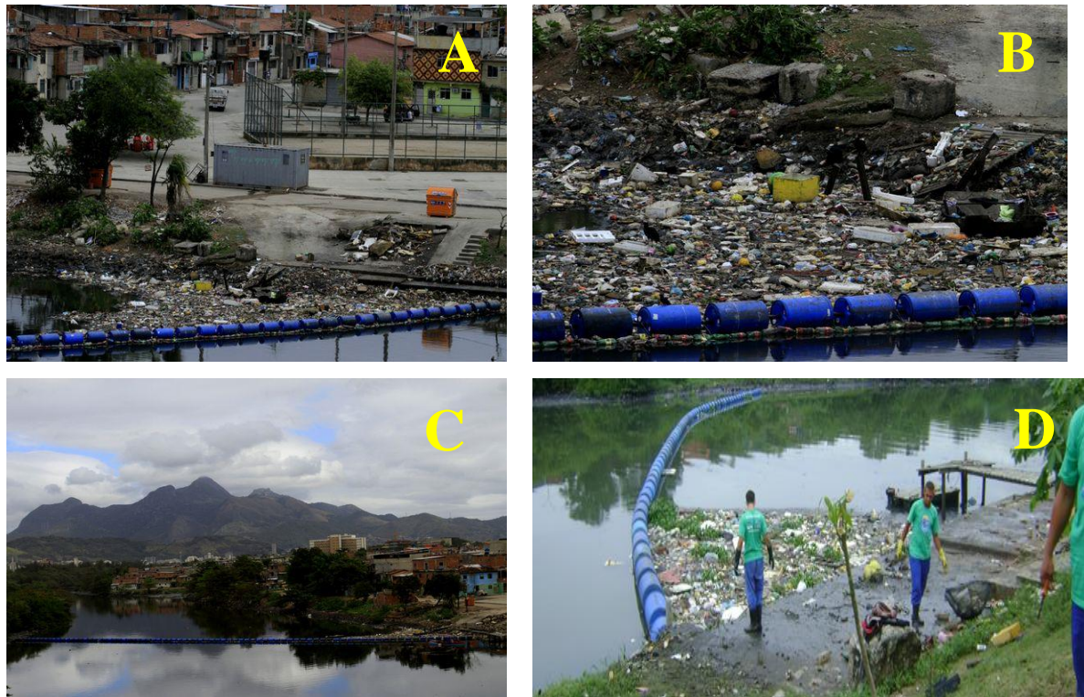
Figura 4 – Estrutura de bombonas flutuantes para conter o lixo no Rio Irajá (A); Detalhe da ecobarreira (B); Aspecto de corpos hídricos isentos de lixo (C); Manejo da ecobarreira (D).
